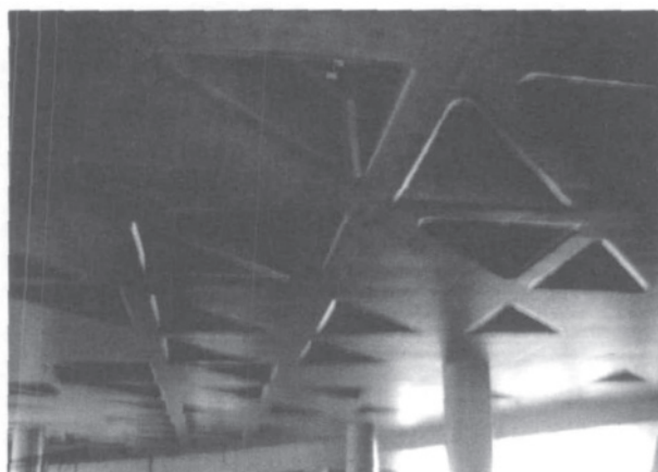
图 7 室外平台下部空间三向斜交梁施工完成后相片
